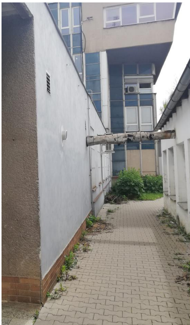
Pohled mezi objekty na pozemku 4029/34 a 4029/26 - spojovací konstrukce nesoucí vnitřní rozvody
